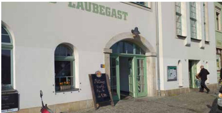
■ Vijci na fasadi pripremaju kuće za mobilne barijere u slučaju porasta vodostaja. Dresden, 2019. © Thomas Hartmann.
