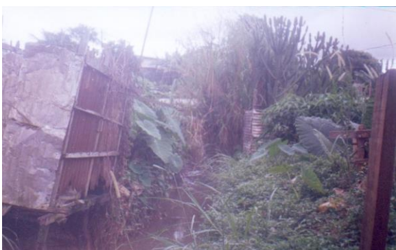
Photo 4 : Latrines à canon établies sur la Mingoa
